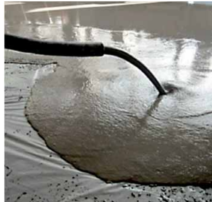
Calciumsulfat-Fließestrich 4.0 ohne Bewehrung
