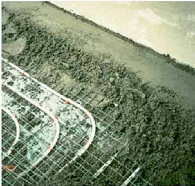
Konventioneller erdfeuchter Zementestrich mit Bewehrung
