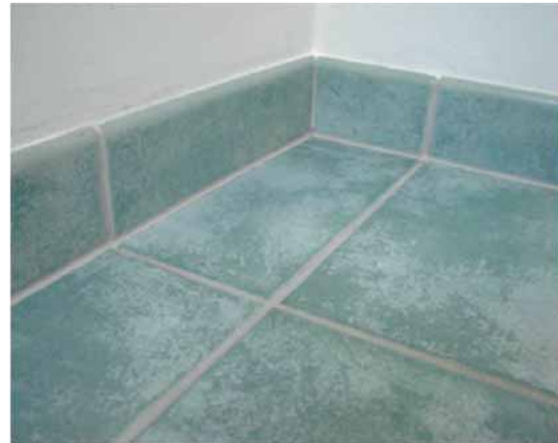
Mit Fließestrich keine Randabsenkung und kein Schüsseln
